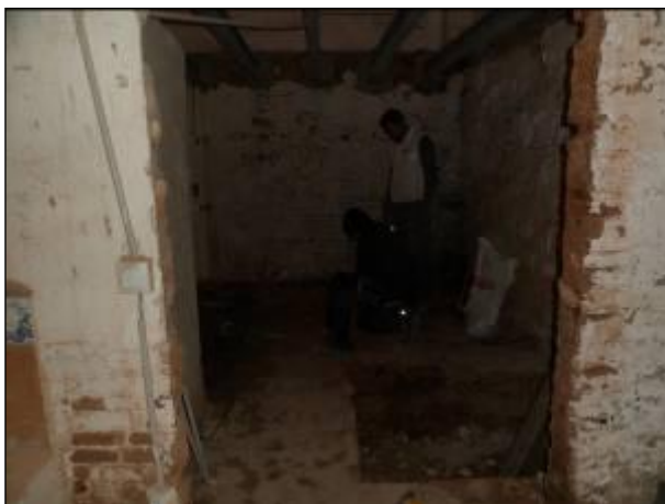
Fig. 15.- Àmbit 1. Vista general. Font: Carles Navarro
