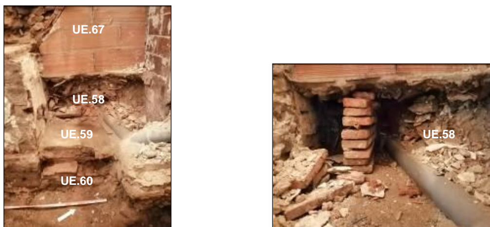
Fig. 41.- Àmbit 2. Vista general de la paret de totxanes UE.67, paviment UE.59 i el rebliment UE.58. Font: Carles Navarro
