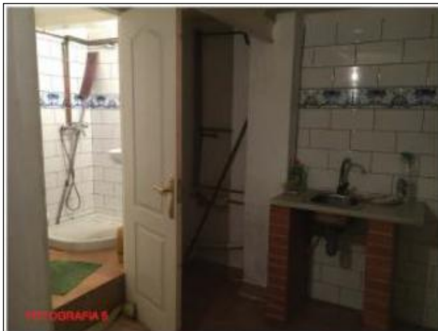
Fig. 12.- Àmbit 1. Vista parcial del WC i pica moderna. Font: Projecte de reforma de local amb afectació puntual de l'estructura. Arquitecte: Jorge Martín Ortega. Maig 2019
